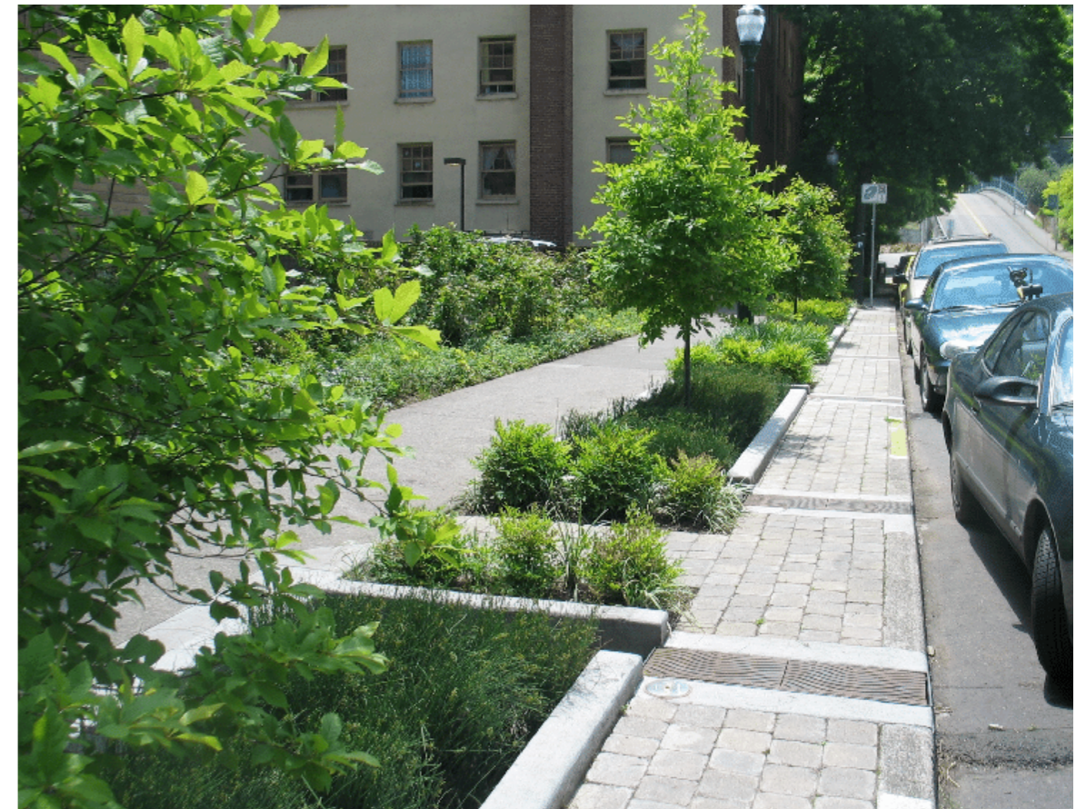
Abb. 19 hydrologisch optimierter Baumstandort
